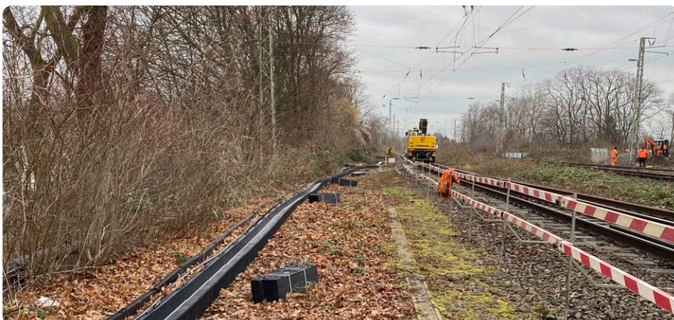
Über 1.000 Meter Kabeltrassen wurde zwischen Dinslaken und Voerde verlegt.
