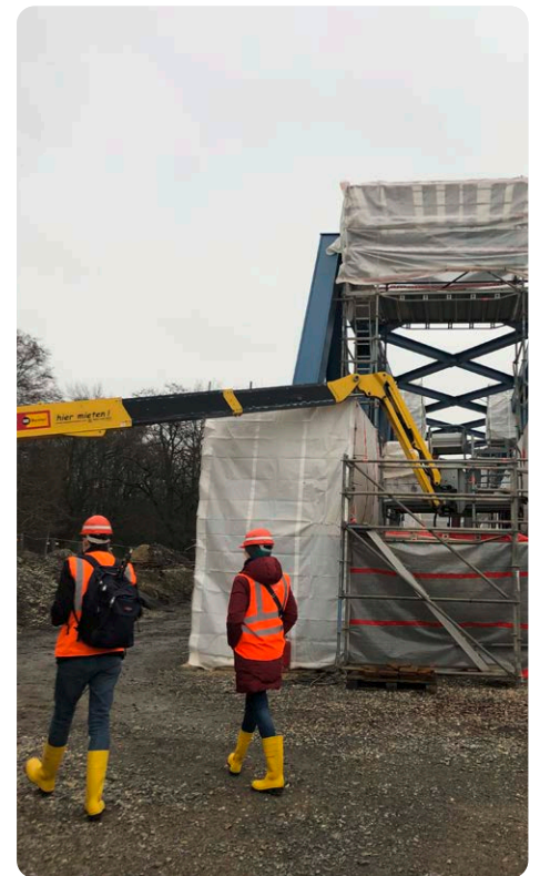
Rhein-Herne-Kanal: Bald geht es hier mit dem Brückeneinschub los.
