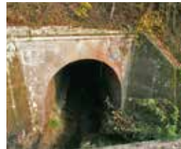
Erhalt von Durchlässen mit potenziellen Fledermausquartieren
