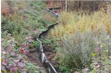
Bauzeitlicher Schutz- zaun für Amphibien bei einem angren- zenden Feuchtgebiet
