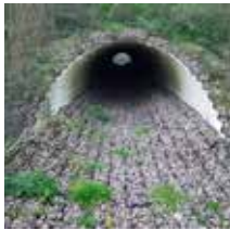
In Abschnitten mit Schallschutzwänden entstehen neue Wild- und Kleintierdurchlässe unter der Bahntrasse.
