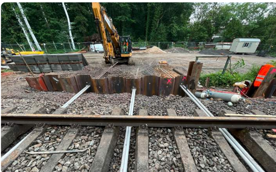
Gleislingsverbau mit Totmannanker als Rückverankerung im Bereich der EÜ Ökotunnel
