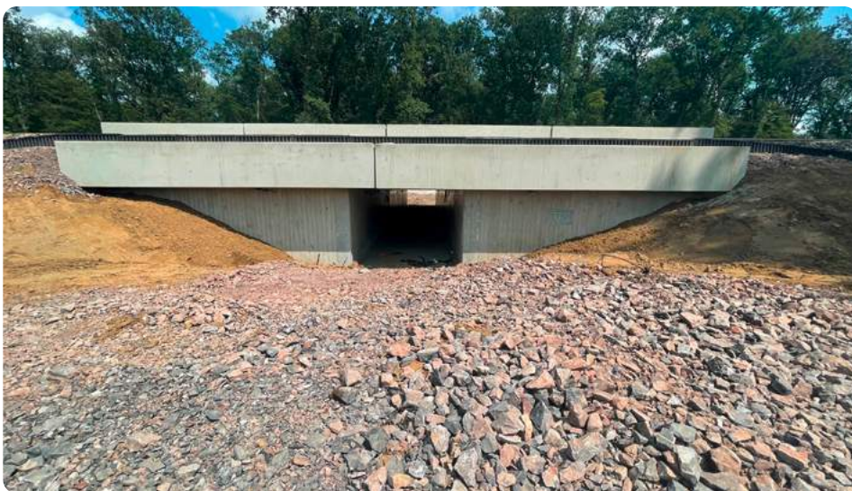
Ostansicht der neu hergestellten EÜ Kleintierdurchlass
