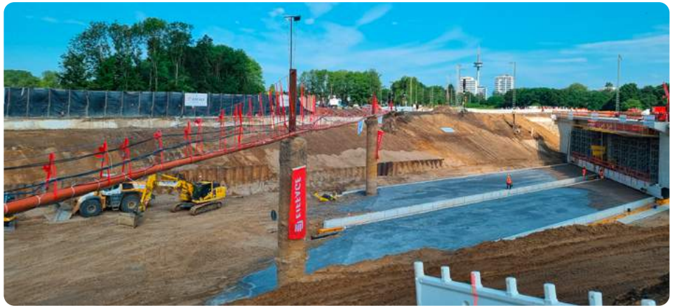
Das neue Brückenbauwerk auf dem Weg zu seinem finalen Standort
