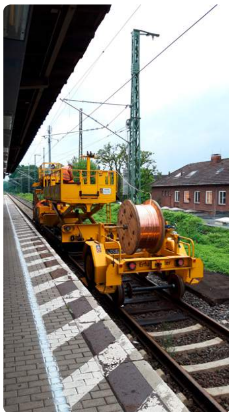
Montage des neuen Kettenwerks an der Oberleitung im Bahnhof (Bf.) Dinslaken
