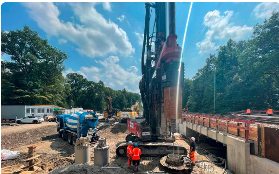
Bohrpfahlarbeiten im Bereich der EÜ Lohberger Entwässerungsgraben
