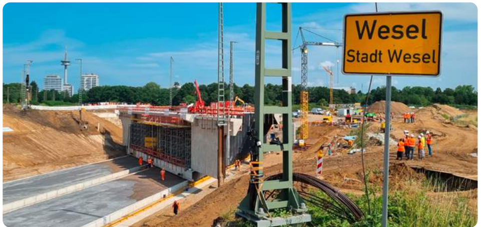
Über die gelben Gleitlager wird das Bauwerk in die richtige Position gebracht.
