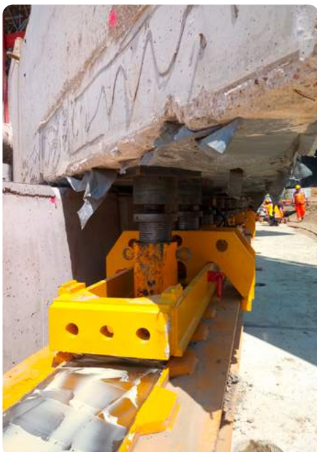
Mit Hilfe der hydraulischen Schub- und Hubvorrichtungen wurde das Bauwerk in seine Endlage gebracht
