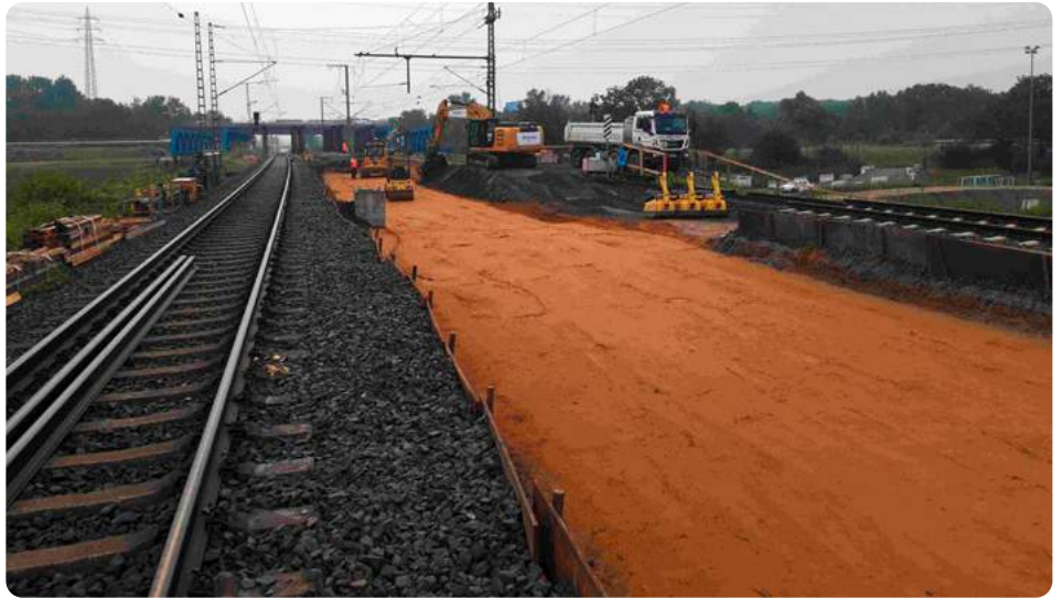
Bodenaustausch Weichenbereich 278/279 (vor der Emscher Brücke)
