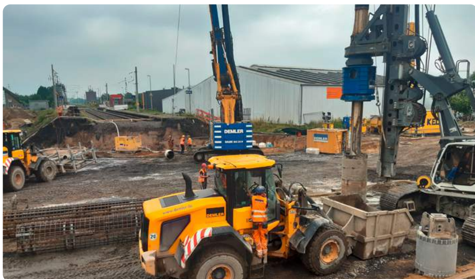
Bohrpfahlarbeiten im Gleisbereich der zukünftigen EÜ Bahnhofstraße (Blickrichtung Oberhausen)
