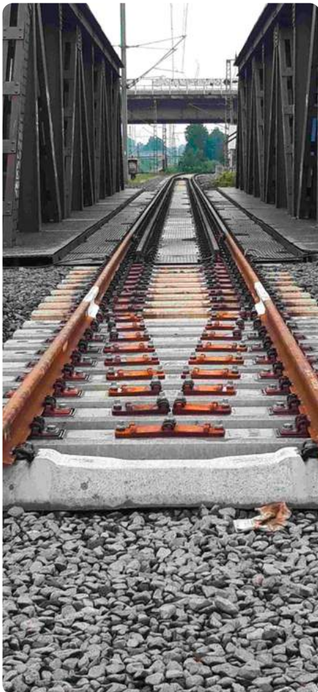
Übergang vom Bauwerk EÜ Emscher auf die anschließende Weiche 279
