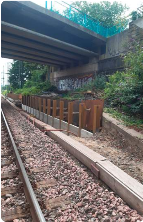
Stützkonstruktion Duisburger Straße Teil 2
