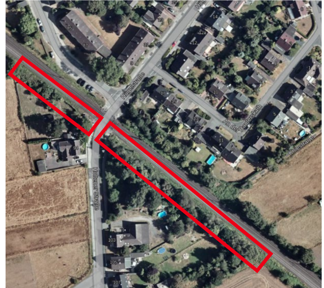
Direkter Bereich des BÜ Holtener Straße
