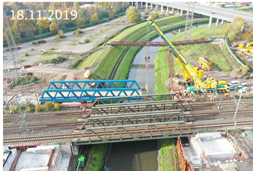
Brückeneinschub Emscherkanal
