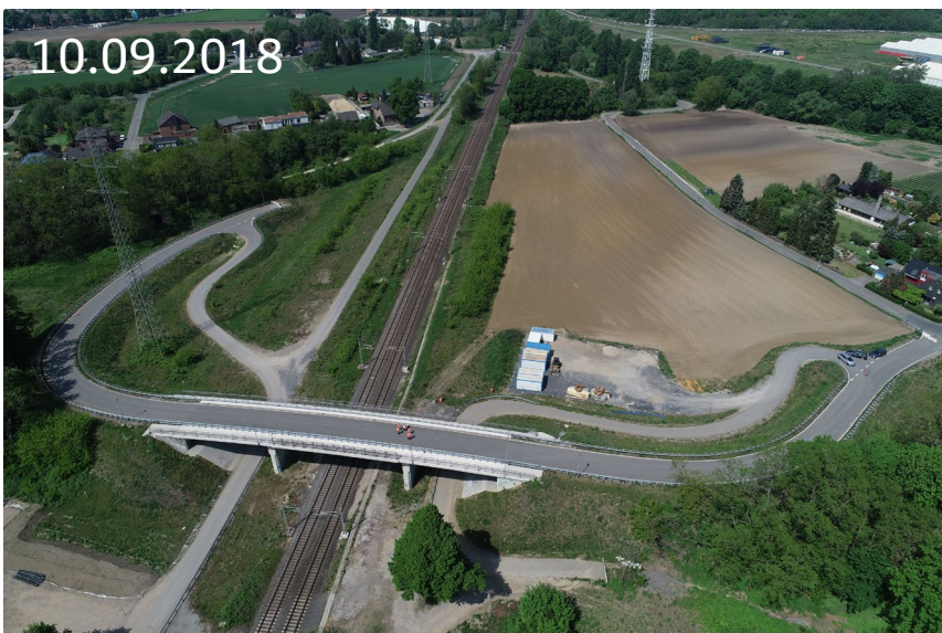
Neubau SÜ Rosa- / Rothofstraße
