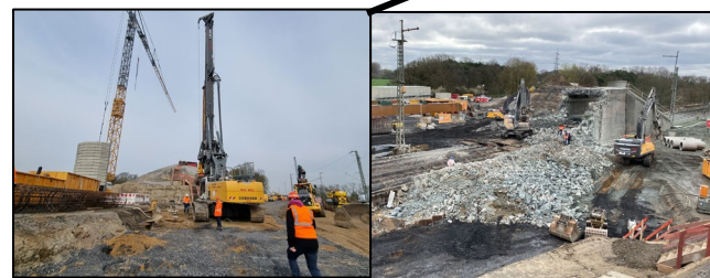
SÜ Willy-Brandt-Str. – Abbruch, Bohrpfähle, OLA-Zusammenhang
