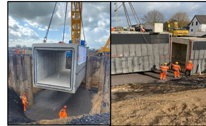
Einhub Block 1 + 2 für die Bestandsgleise an der EÜ Holthäuser Bach/Mommbach:
