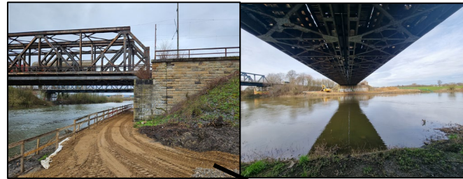
EÜ Lippe Baust Straßen
