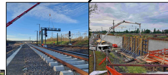
Aufstellen des Signalauslegers in km 2,665
